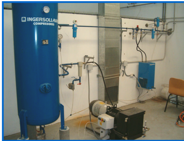
Figura 16. Sistema de generación de aire comprimido
