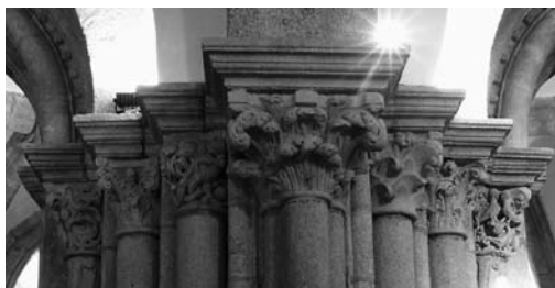
Figura 3. Santiago de Compostela, Catedral, cripta occidental, pilar U-w1, capiteles M4-M10 (derecha a izquierda) BTU Cottbus, Lehrstuhl Baugeschichte, Anke Wunderwald
