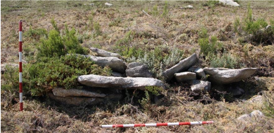
Figura 35. Sector Norte del lienzo Este. Aquí el parapeto pétreo todavía conserva varias hiladas.
