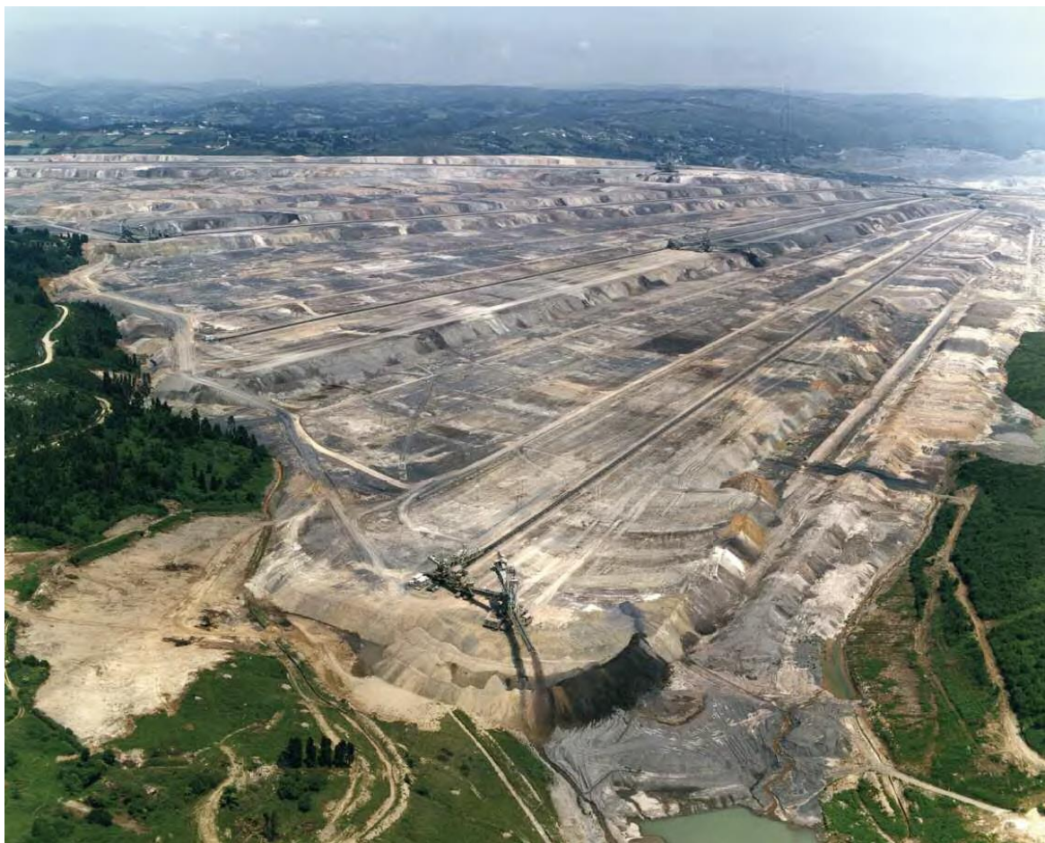
Figura 4. Escombrera exterior vista desde el monte Forgoselo en 1989 (Aréchaga et al. , 2011)
