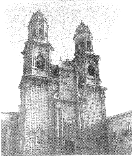
Fig. 14.- Fachada de la iglesia cisterciense de Sobrado (La Coruña).
