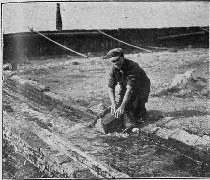
“Mosquita”, lavando su ropa en el agua sucia, pero tibia, del desagüe de los elevadores de granos
