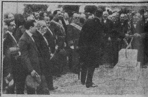
Momento de colocar la piedra fundamental del futuro edificio
