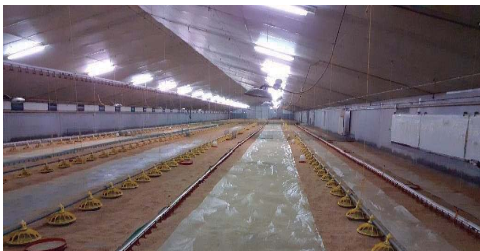
Figura 9. Nave preparada para la recepción
