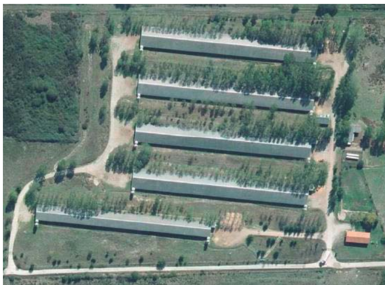
Figura 53. Vista aérea del núcleo avícola Moreiras
