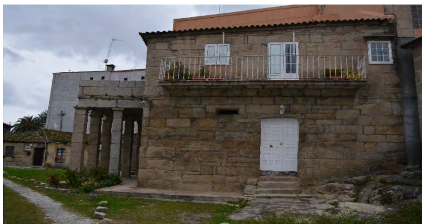
Figura 47. Fachada lateral del edificio de la leprosería. Belén Álvarez Pérez, 2018.
