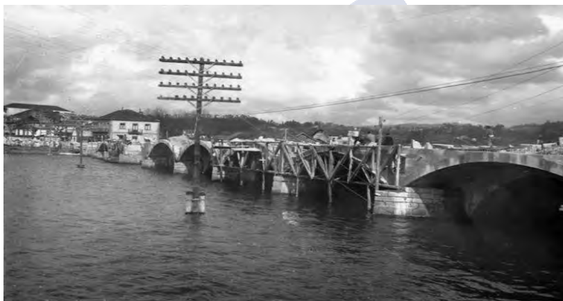
Figura 52. Vista del puente del Burgo, 1954. Exposición Puente del Burgo, 2018. (Museo de Pontevedra)
