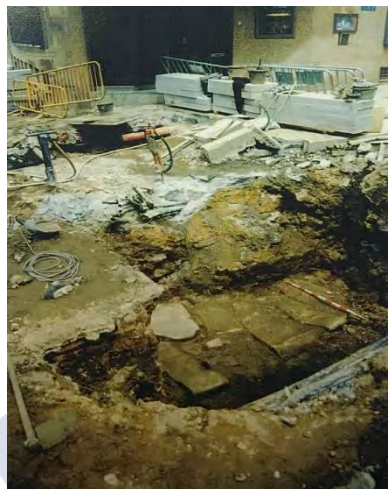
Figura 76. Pavimento de losas en la calle Michelena. En: RODRÍGUEZ SAIZ, E., 2005.
