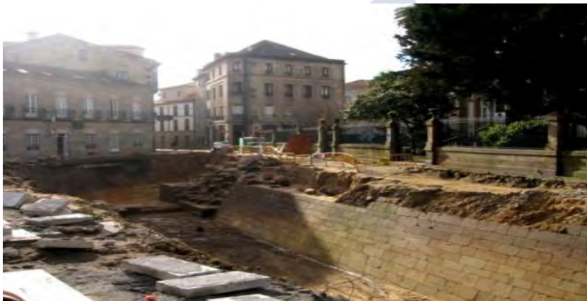
Figura 92. Foso con paramento escarpado. En: CHAO ÁLVAREZ, F. J., 2007.
