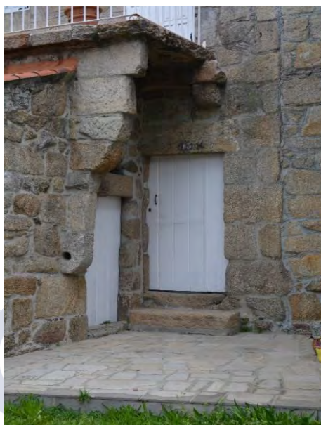
Figura 48. Detalle fachada principal leprosería. Belén Álvarez Pérez, 2018.
