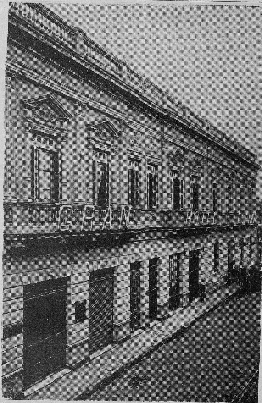
FRENTE DEL EDIFICIO
