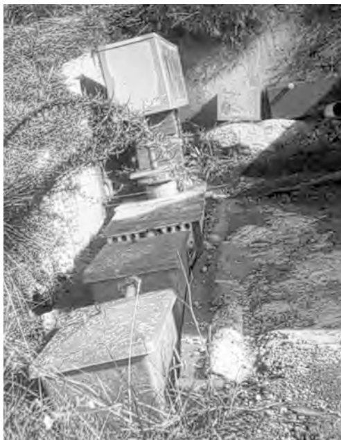
Figura 4. Sistema de captación de las pérdidas de suelo.
