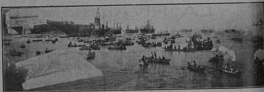
La bahía al lanzarse el primer bloque de cemento para las obras
