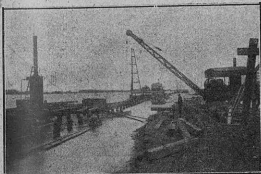
Estado actual del gran muelle Lacroze que se está construyendo sobre el río Paraná
