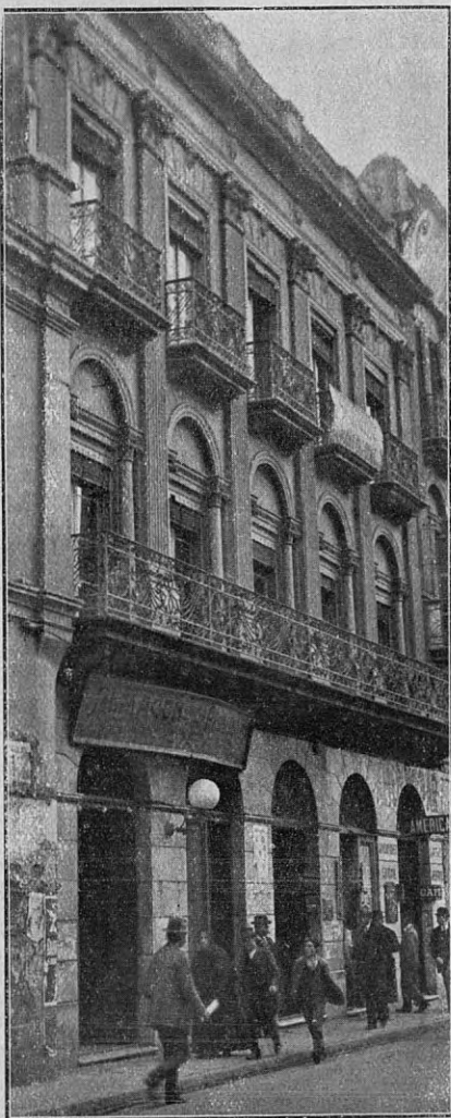
El edificio de Rasetti, Rivadavia, 511-21. "A la propiedad del señor Rasetti, construcción antigua, se le fija un precio que da un promedio de 540 pesos el metro cuadrado, y al edificio moderno, bien concluido, de La Estrella y América, compuesto de varios pisos, se le fija a la construcción el precio de 560 pesos el metro cuadrado." (Informe del doctor Monsegur)
