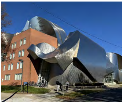
(a) Edificio Peter B. Lewis. Recuperado de [40].
