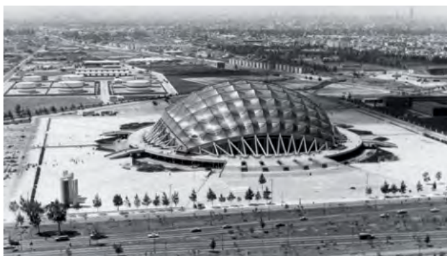
Figura 3.8: Palacio de los Deportes. Recuperado de [8].
