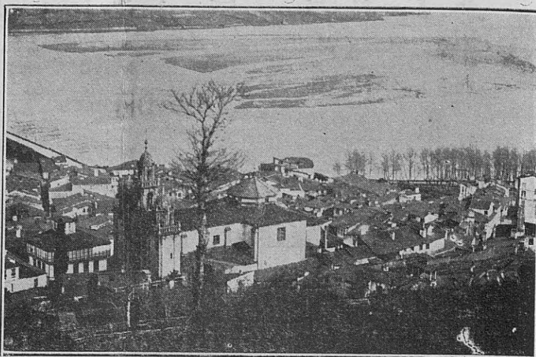
VISTA PARCIAL DE PUENTEDEUME
