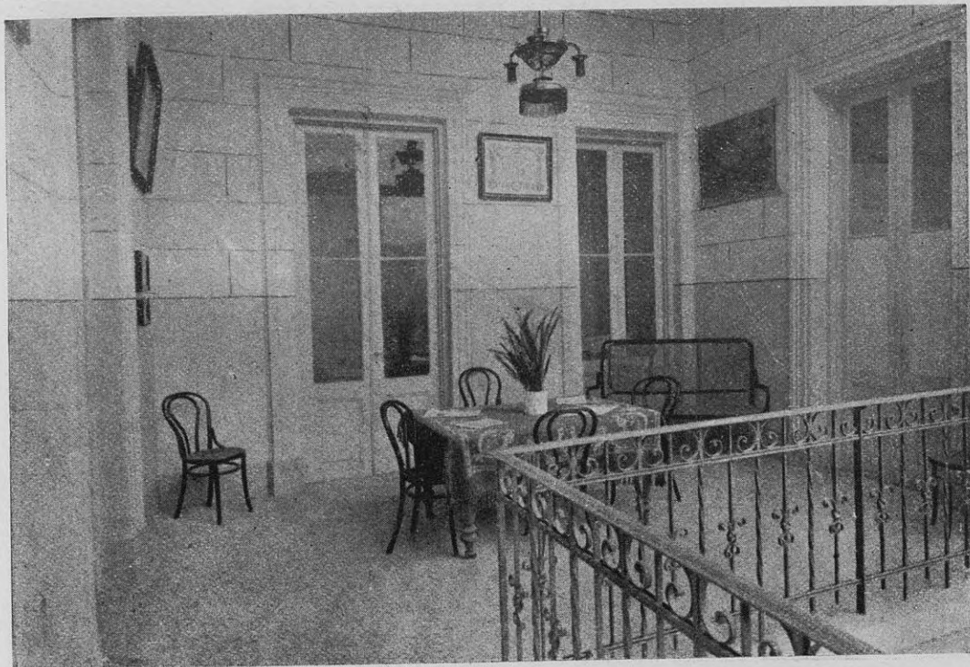
VESTÍBULO PLANTA ALTA
