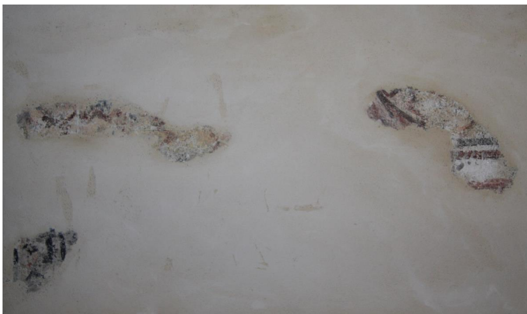
Fig. 33: Detalle dos restos do marco que pechaba o remate da representación da santa Catalina e unha posible inscrición, no Tramo A do presbiterio de Nogueira.
