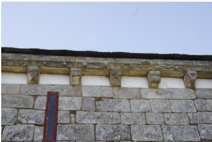
Fig. 2: Detalle dos canzos e das figuras esculpidas na cornixa do muro sur da nave da igrexa.
