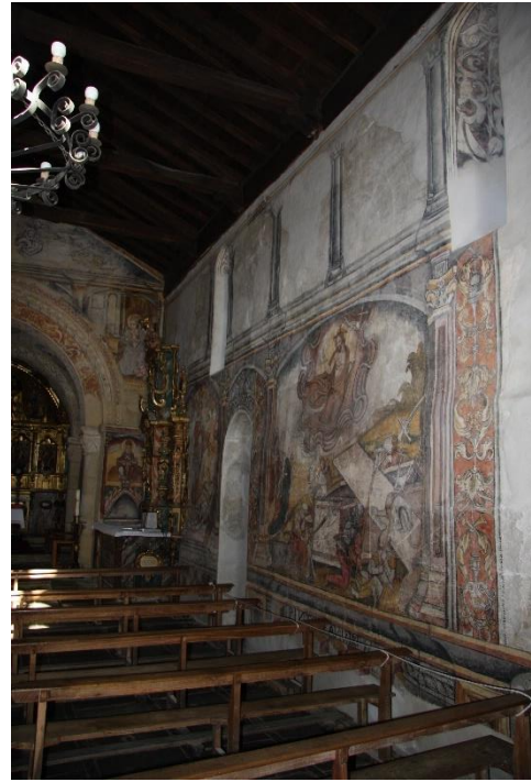
Fig. 53: Extremo sur da nave.
