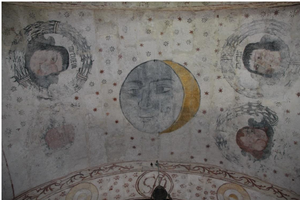
Fig. 43: Detalle do tramo occidental da bóveda de Nogueira.
