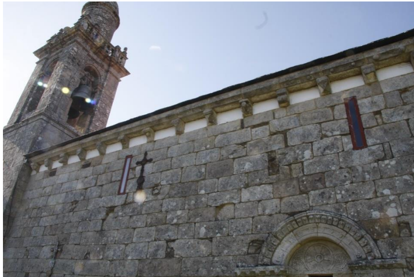
Fig. 1: Muro sur do exterior da nave de Santa María de Nogueira de Miño. Aprécianse os detalles dos canzos.
