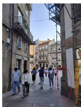
Fig. 48: Guardacantón en el acceso desde Casas Reais y las Algalias (Autor)
