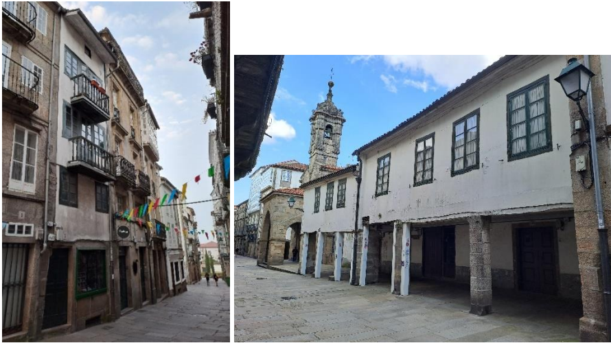
Fig 26-27: Fig.26: Azabachería nº3 (Autor). Fig.27: Rúa Nova nº29 y nº31. Tipología de sotoo e sobrado sobre esteos (Autor)
