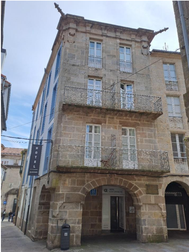
Fig. 57: “Casa Barroca” en el Cantón de San Bieito. Clemente Fernández Sarela (Autor)
