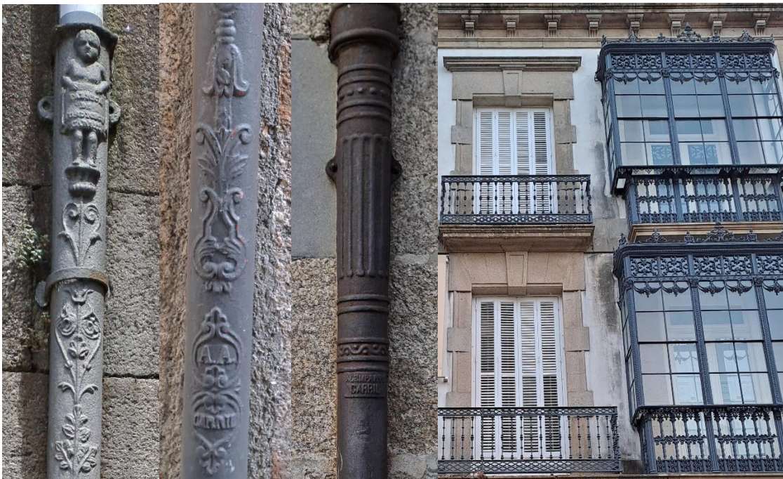
Fig.73: Canalones históricos de fundiciones carrilexas (Fábrica de Fundición de Carril y Alemparte). Elementos de fundición en el Banco de Olimpio Pérez (balcones fabricados por Alemparte). (Autor)
