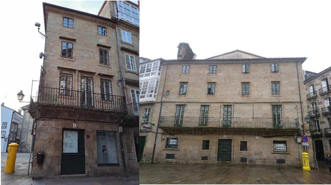
Fig.83: Frontes de la antigua Casa Consistorial en su estado actual. Izquierda: Preguntoiro. Derecha: Praza de Cervantes (Autor)
