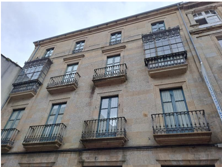
Fig.111: Número 19 de Rúa del Vilar, único ejemplo de miradores de fundición encontrado en la “almendra”. Corresponde a proyecto de 1895 realizado por Manuel Pereiro Caeiro (Autor)
