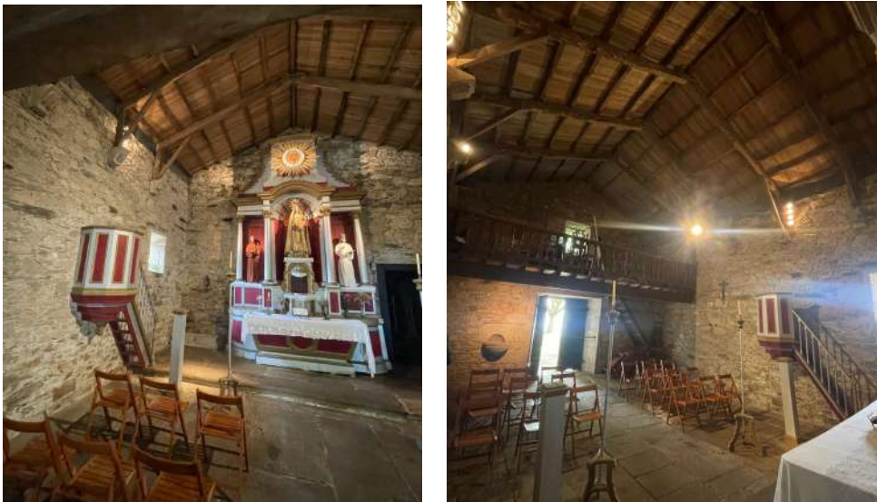
Figuras 10 e 11: Interior da capela barroca do pazo da Merced con teito de madeira a dúas augas e o coro alto de madeira.
