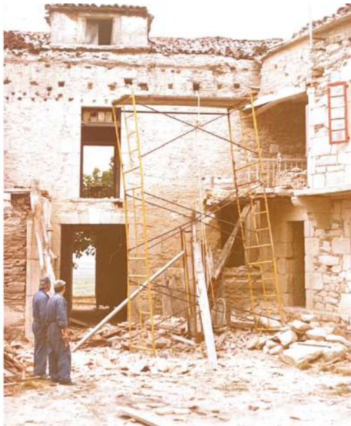
Figura 31: Fotografía dos obreros traballando no pavillón do s.XVIII.
