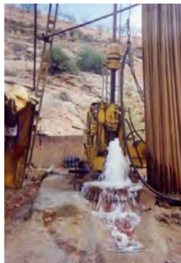
Ilustración 18: Perforación de pozo
