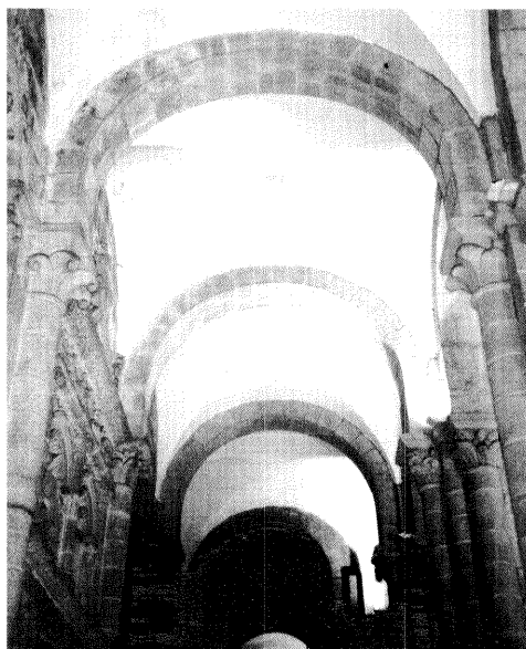
Foto 2.- Arcos fajones en la nave lateral del transepto sur.
