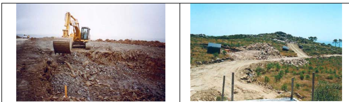
Figura II.62. En ocasiones los afloramientos rocosos requieren para su perforación la práctica de voladura con explosivos. El material suelto producido por la perforación es retirado mediante una retroexcavadora a vertedero (Parque Sotavento), se utiliza para posterior relleno, o
