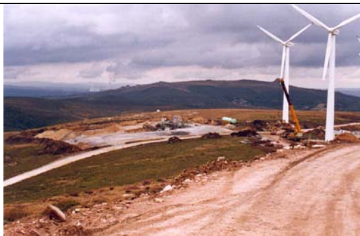
Figura II.31. Planta de fabricación de hormigón en un parque eólico. Parque eólico Carba.
