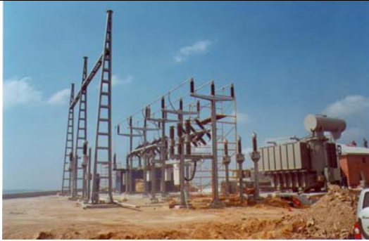
Figura II.101. Momento de instalación de los elementos electromecánicos de la subestación, observándose el pórtico de salida y el transformador. Parque Ameixenda – Filgueira.
