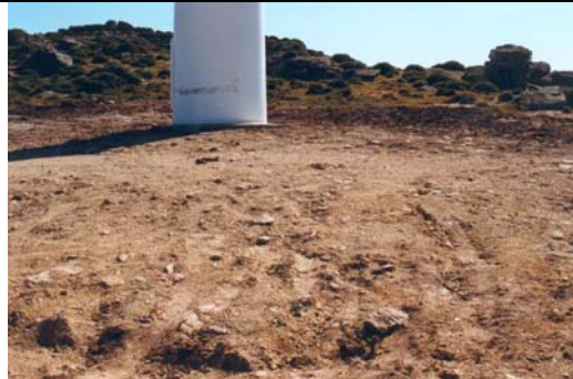
Figura II.72. Sobre dicha base se extiende material procedente de la excavación, que es compactado posteriormente. La plataforma rematada queda así preparada para ser sometida a las labores de restauración. Parque eólico Barbanza II.
