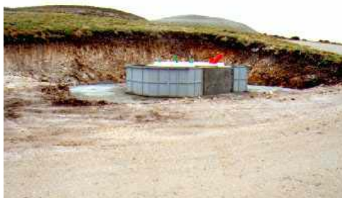
Figura II.66. Posteriormente se procede al armado de la zapata y del pedestal con acero corrugado, incluyendo la pieza metálica a la que se atornilla el primer tramo de la torre. Parque Montouto.
