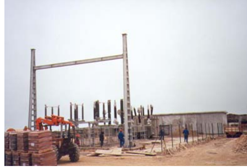
Figura II.99. Vista del talud de la subestación de Ameixenda- Filgueira desde el vial de acceso. También se aprecia la base de sustentación del cierre perimetral del recinto, en la que se enclavarán los postecillos y la alambrada metálica de protección.
