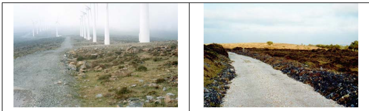
Figura V.18. El impacto paisajístico de los viales viene determinado en gran medida por el color de la capa de rodadura. A la izquierda, vial cuya capa de rodadura constituida por serpentinitas muestra un escaso contraste cromático con la vegetación en la Serra da Capelada.
