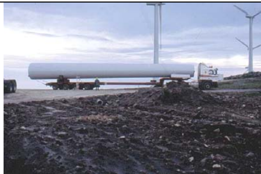
Figura II.88. Los componentes del rotor se distribuyen sobre el terreno previamente a la instalación de los tramos de la torre. El pedestal es la referencia para ubicar los elementos del aerogenerador. La góndola se apoya sobre una bancada que facilita su movilización y manejo, hasta su colocación definitiva. Parque Ameixenda-Filgueira.
