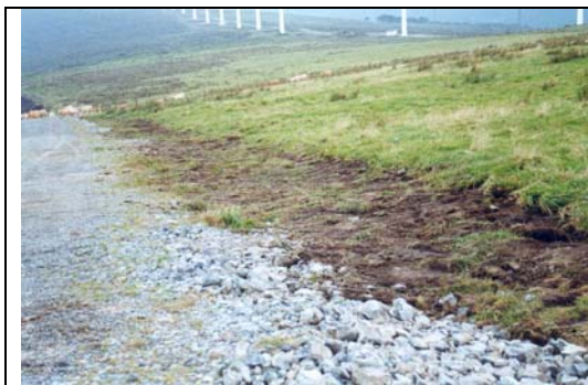
Figura V.11. Detalle de las superficies afectadas en las que se ha eliminado la zanja de drenaje para favorecer la reinstalación de las condiciones hidromorfas. Parque eólico Capelada.
