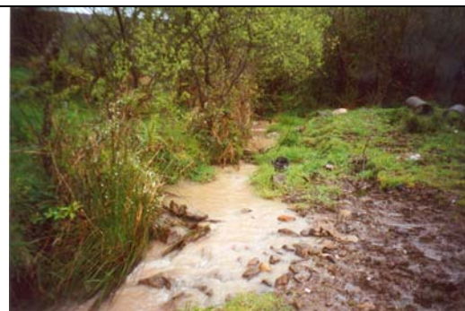
Figura V.12. La remoción de material terrígeno puede provocar aumentos notables en la turbidez de los arroyos del área de afección, durante la fase de construcción. Parque eólico Ventoada.
