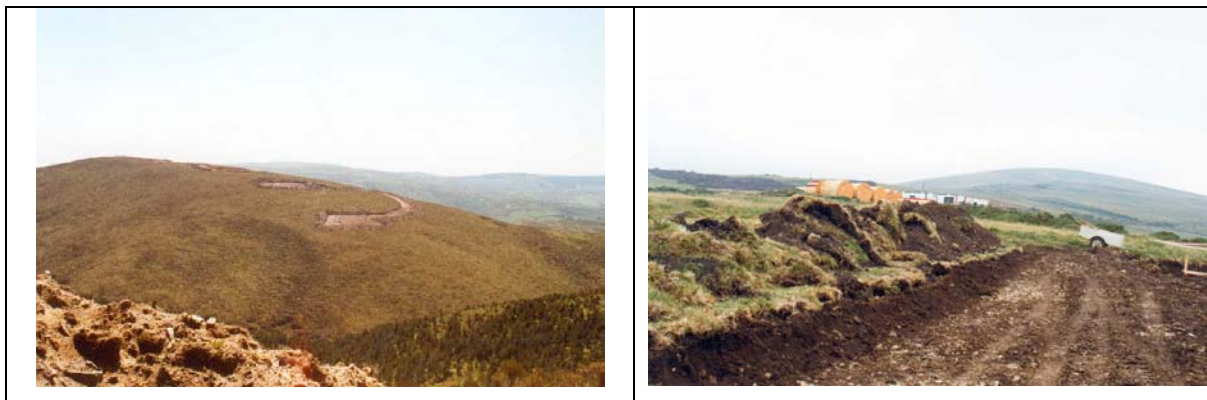
Figura II.40. Vista general de las labores de apertura de viales en la ladera de un monte y aspecto de dos explanaciones para la construcción de las plataformas de los aerogeneradores. Parque eólico Refachón.
