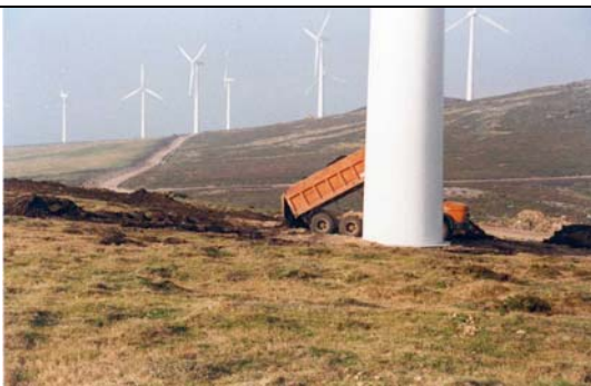
Figura II.74. Ilustración de la operación de aporte de la tierra vegetal reservada al efecto sobre una plataforma eólica mediante un camión volquete, que la distribuye de forma homogénea.
