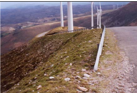
Figura II.54. En situaciones muy especiales, tramos con excesiva pendiente, los viales son rematados con la instalación de una bionda a modo de quitamiedos. Parque Alabe-Soán
