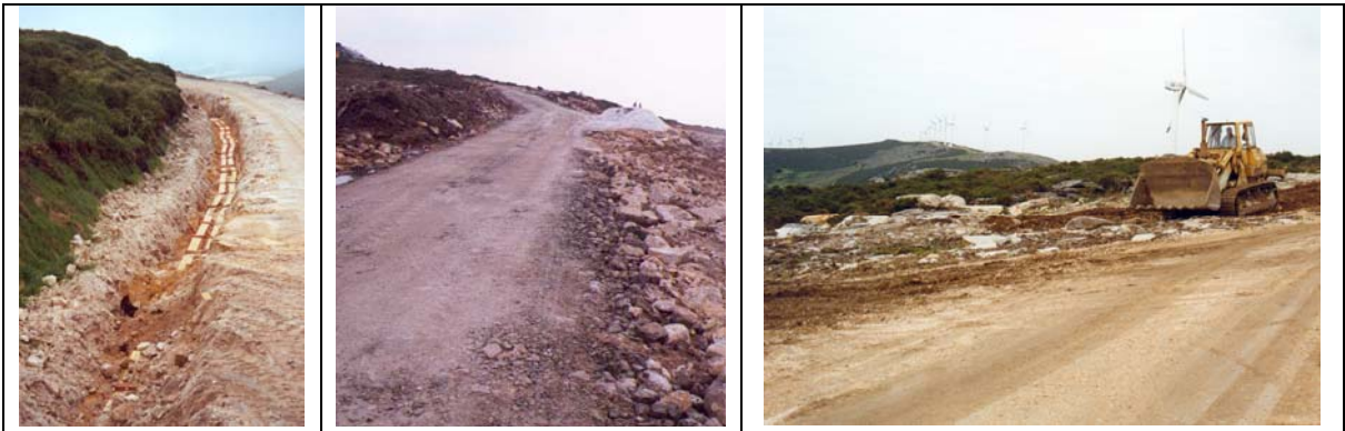
Figura II.82. Las placas de polietileno señalan la presencia de cables enterrados en la zanja, una vez extendida y compactada la capa de arena que los cubre. Parque eólico Alabe – Lomba.
