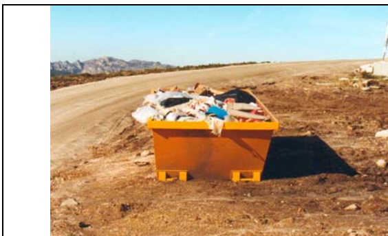
Figura II.107. La retirada de este tipo de material se realiza en las últimas fases de construcción del parque mediante el empleo de contenedores. Parque eólico Virxe do Monte.
