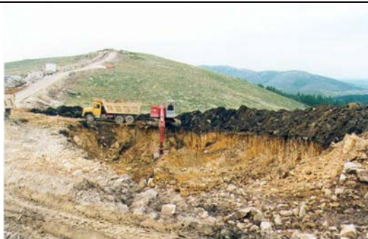
Figura II.32. Vista general de un hueco de excavación para la extracción de material de préstamo. Generalmente la excavación se delimita con un vallado a fin de prevenir la caída accidental de animales en libertad o personas. Parque eólico Ameixenda – Filgueira
