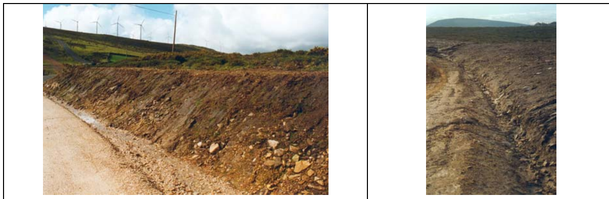
Figuras II.55 y II.56. Una vez remodelados los taludes, se procede a la limpieza del borde del vial (Parque eólico A Ruña), configurando la forma definitiva de la cuneta (Parque Villalba).
