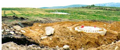
Figura II.68. Aspecto de un pedestal ya finalizado, con su forma hexagonal u octogonal. Parque eólico Montouto.
