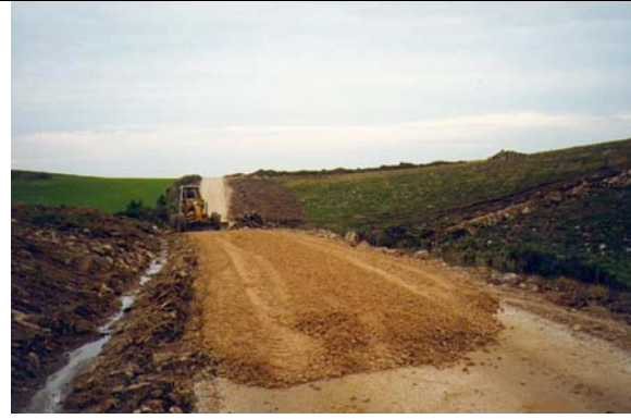
Figura II.50. El paso de maquinaria pesada determina en ocasiones la reconstrucción o la adecuación de algunos tramos de vial a fin de atenuar sus efectos y durante toda la fase de construcción del parque eólico. Parque eólico Virxe do Monte.
