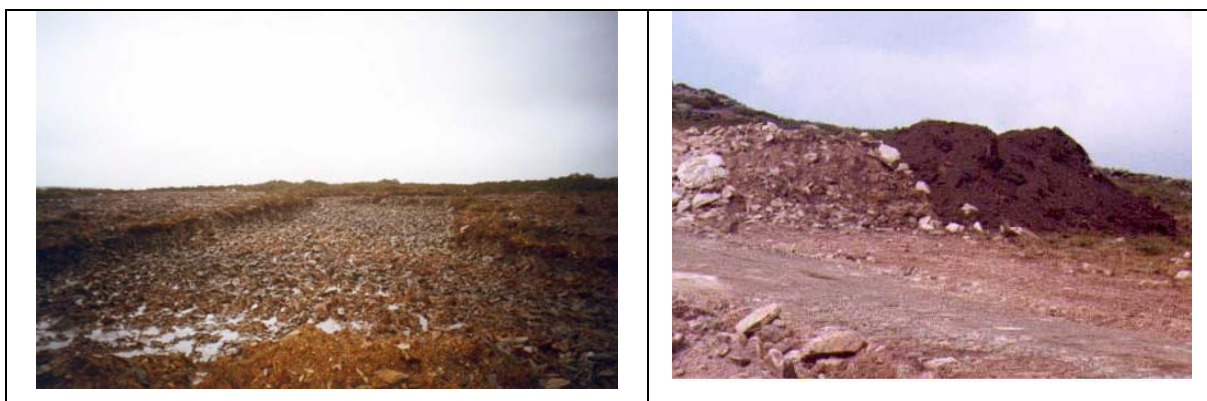
Figura II.42. Detalle de una superficie recién desbrozada, preparada para la construcción del vial que se inicia con la extensión de la subbase de zahorra. Parque Sotavento.
