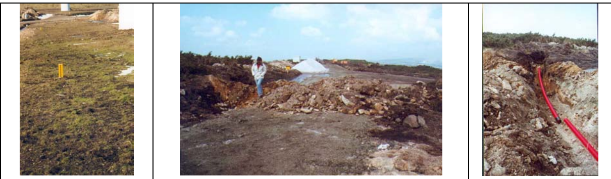
Figura II.85. Aspecto de una zanja ya revegetada a base de gramíneas, cuyo trazado se marca mediante la colocación de hitos cada 50 m aproximadamente y en los cambios de dirección. Parque eólico Carba.
