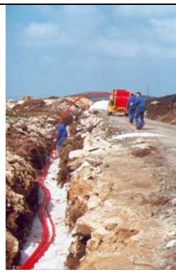
Figura II.78. Apertura de una zanja de conducción de cableado a la derecha del vial con trazado paralelo y colindante a este último. La pala excavadora retira el material de mayor tamaño auxiliada por un camión volquete. Parque eólico Ameixenda – Filgueira.
