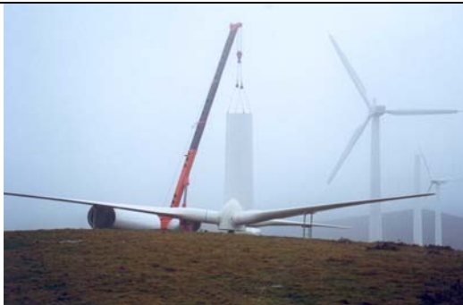
Figura II.89. El transporte de la torre en tramos se realiza en coordinación con el montaje, mediante un camión equipado con una cabeza tractora y caja de tamaño adecuado a la longitud de las secciones y amarres especiales para sostener su estructura y forma cilíndrica. Parque eólico A Ruña.
