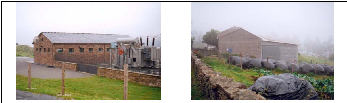
Figura V.16. El centro de explotación del parque Montouto es un ejemplo de adecuada integración paisajística. Sus dimensiones, material de construcción y acabado son similares al de una construcción tradicional destinada a uso ganadero, actividad característica de la zona de estudio.
