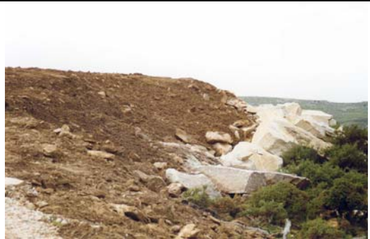
Figura II.72. Sobre dicha base se extiende material procedente de la excavación, que es compactado posteriormente. La plataforma rematada queda así preparada para ser sometida a las labores de restauración. Parque eólico Barbanza II.
