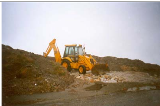
Figura II.44. Una vez extendida y compactada la capa de zahorra de tamaño bloque, se procede a la extensión de una segunda capa de material más fino. Parque eólico Sotavento.
