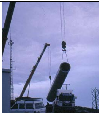
Figura II.91, 92 y 93. El manejo de los tramos a instalar se realiza mediante una grúa de grandes dimensiones, que soporta todo el peso de la estructura, auxiliada por otra de menor envergadura que sujeta la torre por el extremo opuesto, a fin de evitar el vaivén del elemento a instalar. Dos operarios que se encuentran en el extremo superior de la escalerilla interna del tramo instalado, reciben y ajustan la nueva sección. Parque eólico A Ruña.
