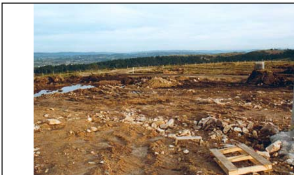
Figura II.105. Los huecos de excavación son rellenados con aportes de material sobrante y posteriormente restaurada la topografía original en la medida de lo posible. Parque Virxe do Monte.
