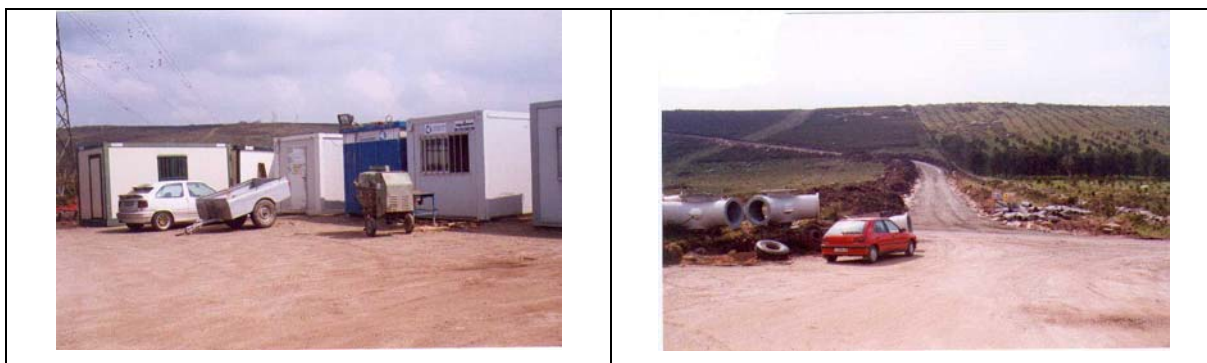
Figura II.29. Ejemplo de una zona de instalación de las casetas de obra durante la construcción del parque eólico Ameixenda- Filgueira.
