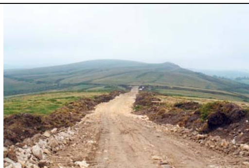
Figura II.46. En el terraplén lateral derecho de este vial se puede apreciar la disposición de las dos capas de zahorra extendidas y compactadas. Parque eólico Barbanza II.
