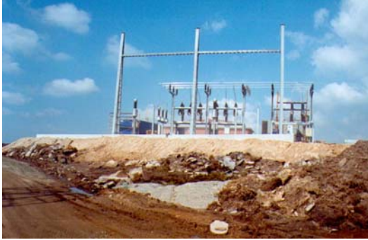
Figura II.99. Vista del talud de la subestación de Ameixenda- Filgueira desde el vial de acceso. También se aprecia la base de sustentación del cierre perimetral del recinto, en la que se enclavarán los postecillos y la alambrada metálica de protección.
