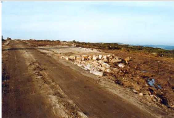
Figura II.52. Las ampliaciones en garaje de los viales se construyen con una base de zahorra de unos 10 cm de espesor. Parque eólico A Ruña.
