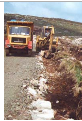
Figura II.78. Apertura de una zanja de conducción de cableado a la derecha del vial con trazado paralelo y colindante a este último. La pala excavadora retira el material de mayor tamaño auxiliada por un camión volquete. Parque eólico Ameixenda – Filgueira.
