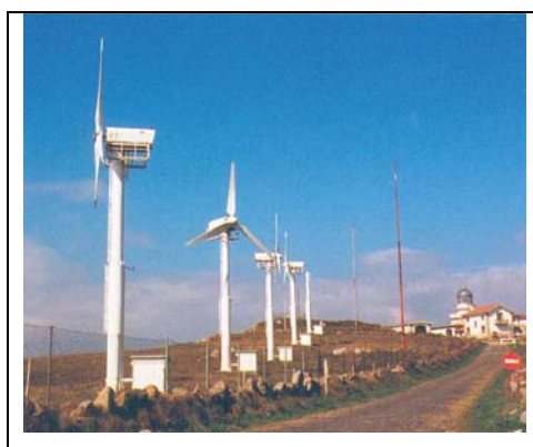
Figura II.9. Parque eólico de Estaca de Bares, en Mañón (A Coruña)
