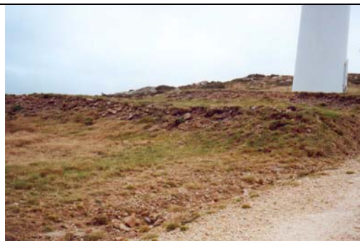
Figura II.76. Posteriormente, la tierra vegetal es extendida en una capa de unos 20-25 cm de espesor, procediendo a su adecuación por encalado y posterior siembra de gramíneas. Carba.
