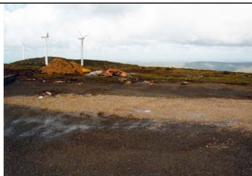
Figura II.105. Los huecos de excavación son rellenados con aportes de material sobrante y posteriormente restaurada la topografía original en la medida de lo posible. Parque Virxe do Monte.
