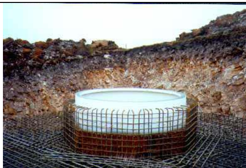
Figura II.66. Posteriormente se procede al armado de la zapata y del pedestal con acero corrugado, incluyendo la pieza metálica a la que se atornilla el primer tramo de la torre. Parque Montouto.
