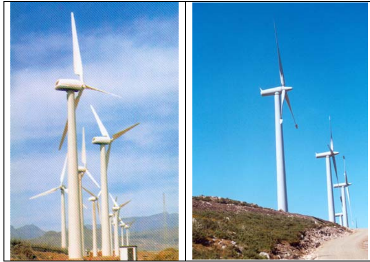
Figura II.115. Sistema de frenado con pala completa girada (izqda.; tomada de LM) o punta de pala girada (dcha. Parque eólico Adraño)
