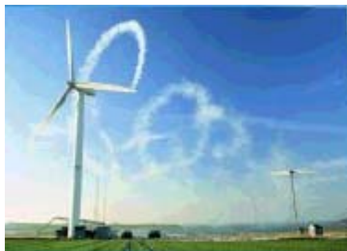
Figura II.4. Aspecto de la estela de un aerogenerador (Tomado de www.lm.dk )
