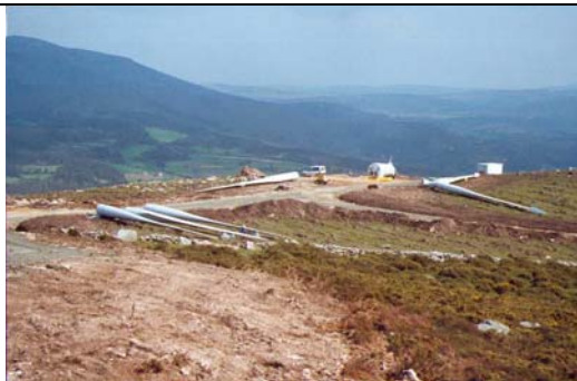
Figura II.88. Los componentes del rotor se distribuyen sobre el terreno previamente a la instalación de los tramos de la torre. El pedestal es la referencia para ubicar los elementos del aerogenerador. La góndola se apoya sobre una bancada que facilita su movilización y manejo, hasta su colocación definitiva. Parque Ameixenda-Filgueira.
