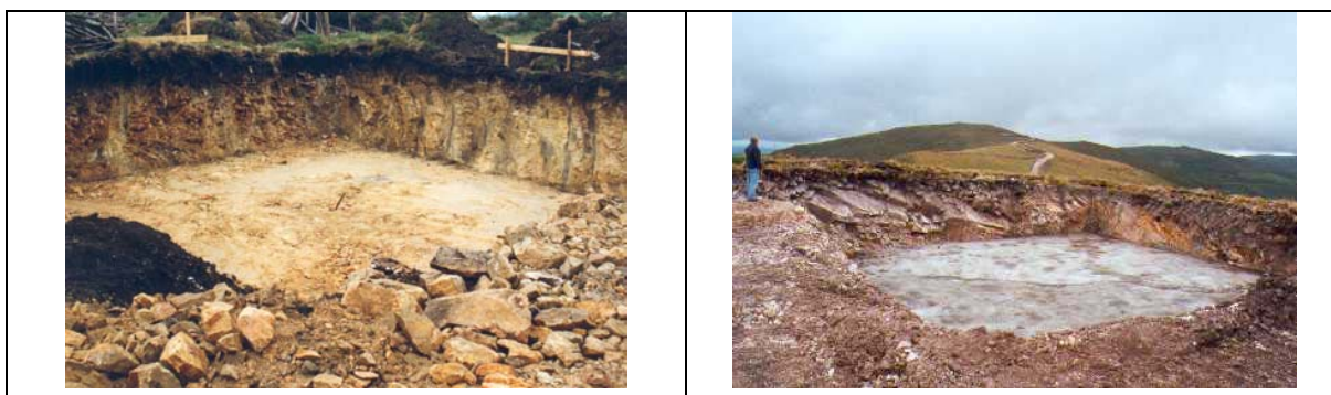
Figura II.64. Aspecto del hueco de cimentación con la base nivelada. El vallado advierte de su posición y previene de posibles riesgos de accidente y de caídas del ganado en libertad. Parque eólico Vicedo.
