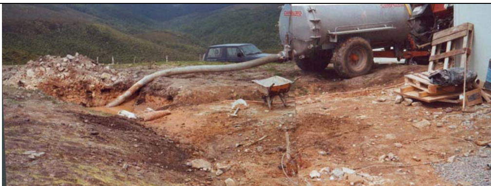
Figura II.36. Las surgencias de agua o su acumulación en periodos lluviosos dificultan las labores de construcción requiriendo el empleo de motores- bomba para su desvío o evacuación. Parque eólico Alabe-Ventoada.
