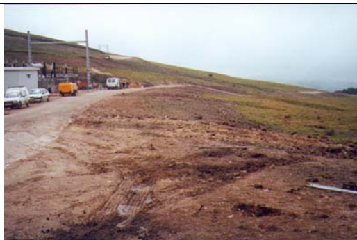
Figura II.48. Aspecto final de un vial con márgenes remodelados, preparado para la restauración de la cubierta vegetal. La ausencia de cuneta se justifica por la suavidad de la pendiente. Álabe-Lomba.
