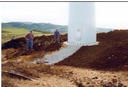
Figura II.76. Posteriormente, la tierra vegetal es extendida en una capa de unos 20-25 cm de espesor, procediendo a su adecuación por encalado y posterior siembra de gramíneas. Carba.
