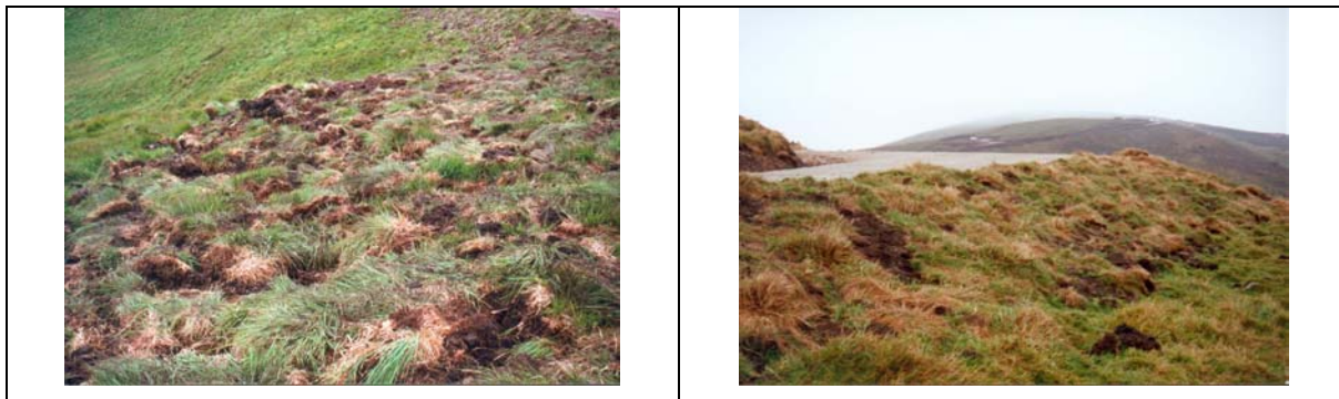
Figura V.14. En la fotografía, detalle de los acúmulos de cepellones en las márgenes de un vial del parque eólico Montouto a la espera de ser colocados
