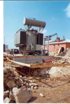
Figura II.101. Momento de instalación de los elementos electromecánicos de la subestación, observándose el pórtico de salida y el transformador. Parque Ameixenda – Filgueira.
