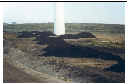
Figura II.74. Ilustración de la operación de aporte de la tierra vegetal reservada al efecto sobre una plataforma eólica mediante un camión volquete, que la distribuye de forma homogénea.
