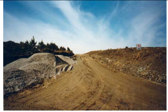
Figura II.50. El paso de maquinaria pesada determina en ocasiones la reconstrucción o la adecuación de algunos tramos de vial a fin de atenuar sus efectos y durante toda la fase de construcción del parque eólico. Parque eólico Virxe do Monte.
