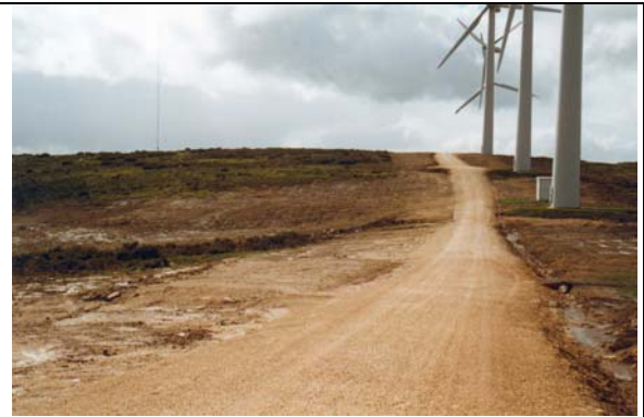
Figura II.52. Las ampliaciones en garaje de los viales se construyen con una base de zahorra de unos 10 cm de espesor. Parque eólico A Ruña.
