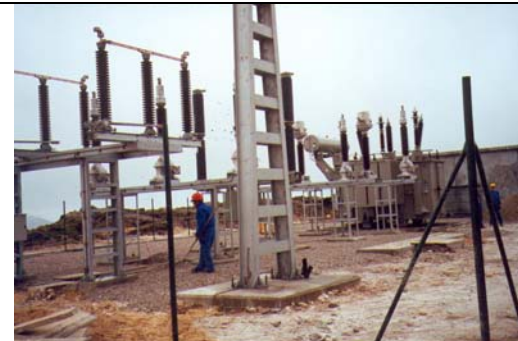
Figura II.103. Una vez instalado el aparellaje completo de la subestación se extiende una capa de grava sobre la base de hormigón. Parque eólico Alabe-Lomba.
