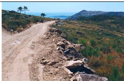
Figura II.46. En el terraplén lateral derecho de este vial se puede apreciar la disposición de las dos capas de zahorra extendidas y compactadas. Parque eólico Barbanza II.
