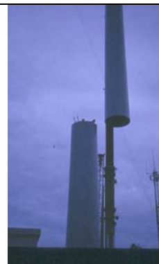
Figura II.91, 92 y 93. El manejo de los tramos a instalar se realiza mediante una grúa de grandes dimensiones, que soporta todo el peso de la estructura, auxiliada por otra de menor envergadura que sujeta la torre por el extremo opuesto, a fin de evitar el vaivén del elemento a instalar. Dos operarios que se encuentran en el extremo superior de la escalerilla interna del tramo instalado, reciben y ajustan la nueva sección. Parque eólico A Ruña.
