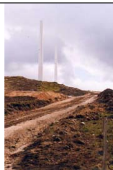
Figura II.44. Una vez extendida y compactada la capa de zahorra de tamaño bloque, se procede a la extensión de una segunda capa de material más fino. Parque eólico Sotavento.
