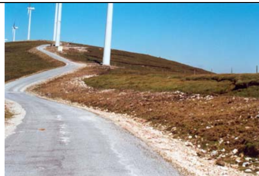
Figura II.48. Aspecto final de un vial con márgenes remodelados, preparado para la restauración de la cubierta vegetal. La ausencia de cuneta se justifica por la suavidad de la pendiente. Álabe-Lomba.
