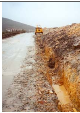
Figura II.78. Apertura de una zanja de conducción de cableado a la derecha del vial con trazado paralelo y colindante a este último. La pala excavadora retira el material de mayor tamaño auxiliada por un camión volquete. Parque eólico Ameixenda – Filgueira.
