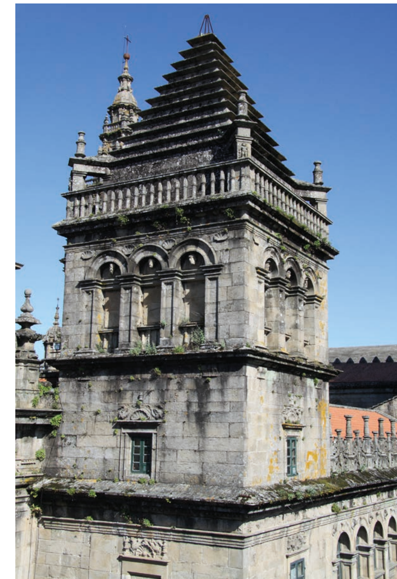
Fig.95 Torre del Tesoro; foto del autor.
