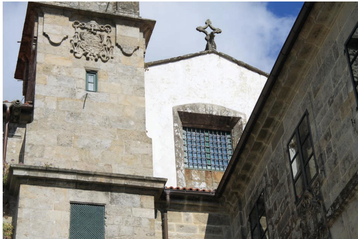
Fig.65 Fachada occidental de la antigua iglesia de Santa María de Belvís; foto del autor.
