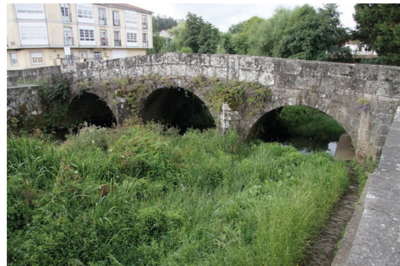
Fig.19 El Puente del Sar; foto del autor.
