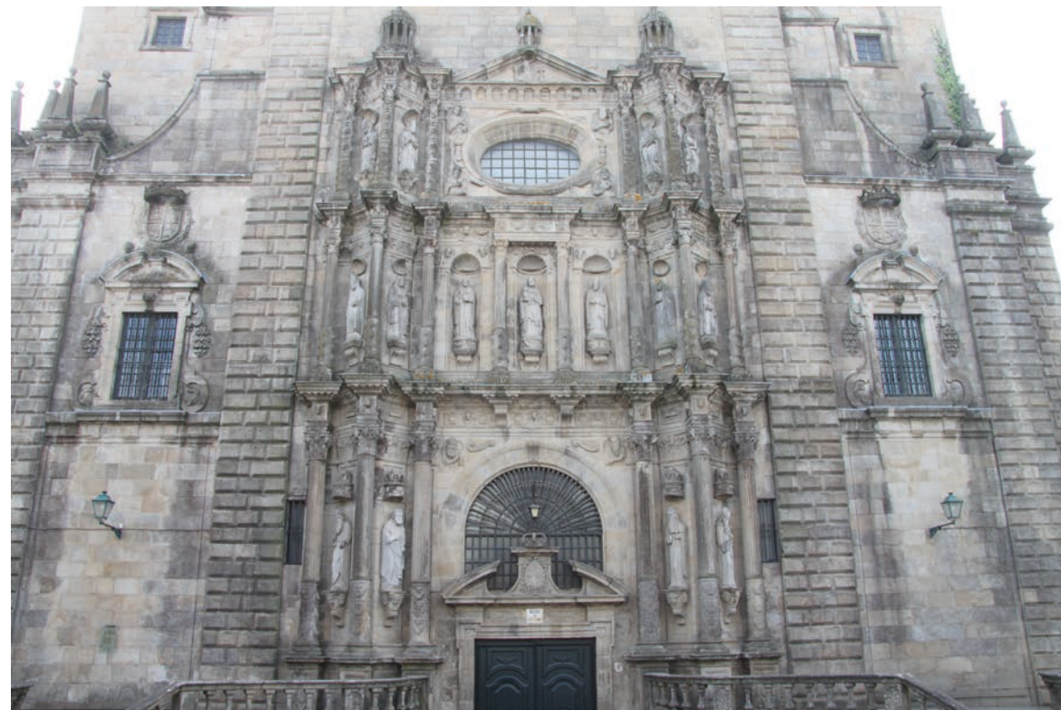
Fig.81 Fachada de la Iglesia de San Martiño Pinario; foto del autor.
