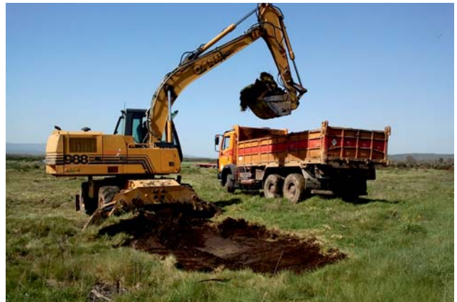
Excavación da parcela.
