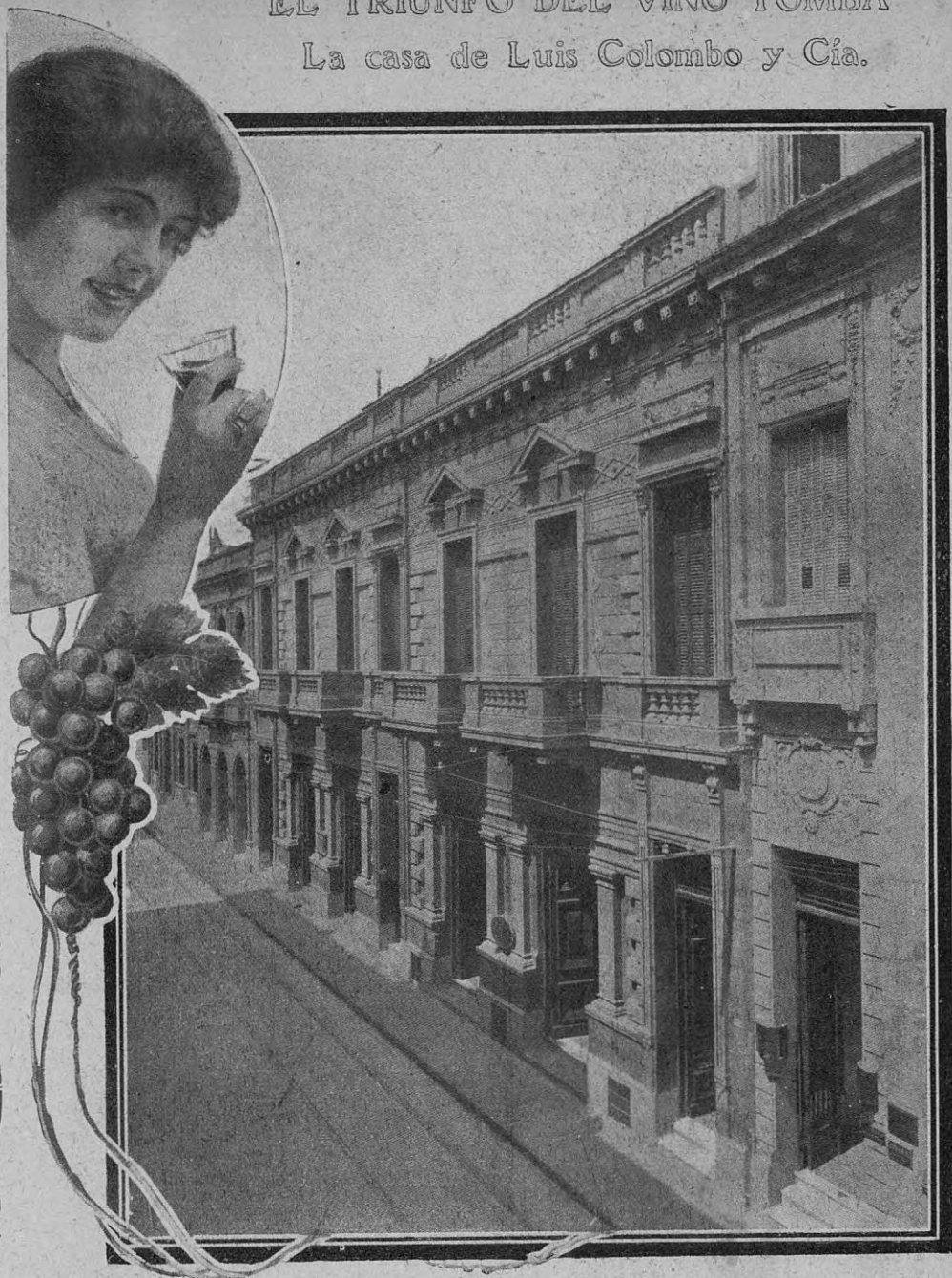
Frente del edificio que ocupa en el Rosario el almacén al por mayor de Luis Colombo y Cía., representantes exclusivos del Vino Tomba en toda la República Argentina
