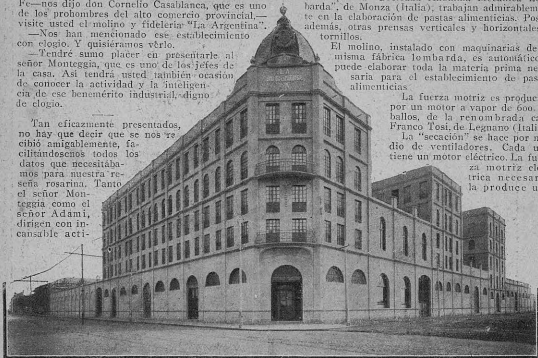
Fronte del edificio ocupado por el Molino y Fiderleria "La Argentina", en la esquina Salta e Iriondo (Rosario) y que es el mejor establecimiento que del citado ramo existe en la provincia de Santa Fe
