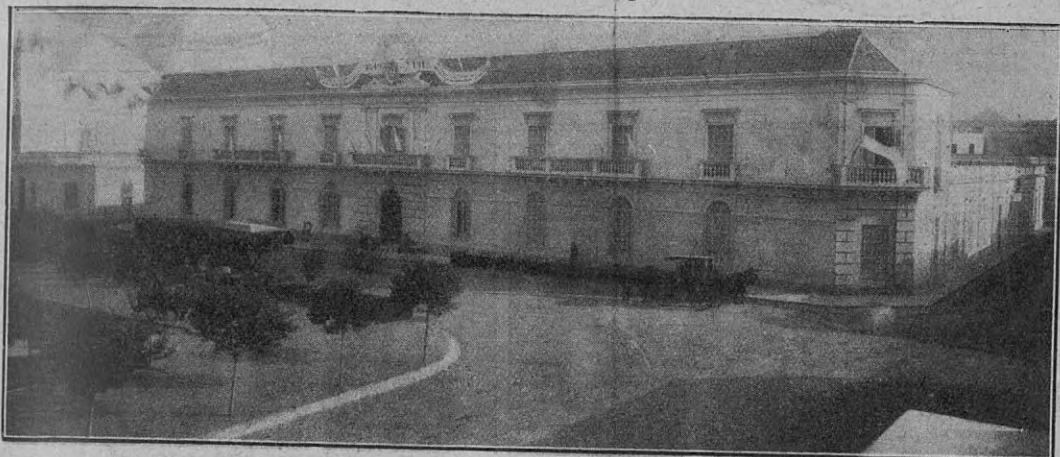
El edificio de la nueva escuela PARANA
