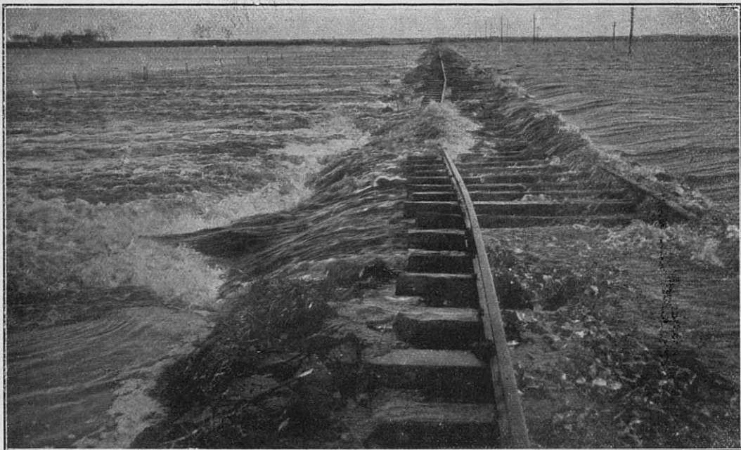
Entre las estaciones General Guido y Maipú. — El agua fácilmente torció los rieles y los dejó en el aire, y de yapa, se llevó el balastro de granito de la vía a respetable distancia
