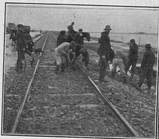
El pueblo de General Guido perforó el terraplén con el propósito de dar paso a las aguas
