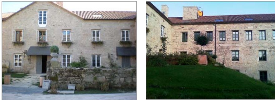
Figuras 5 y 6. Vista exterior del hotel-balneario.
