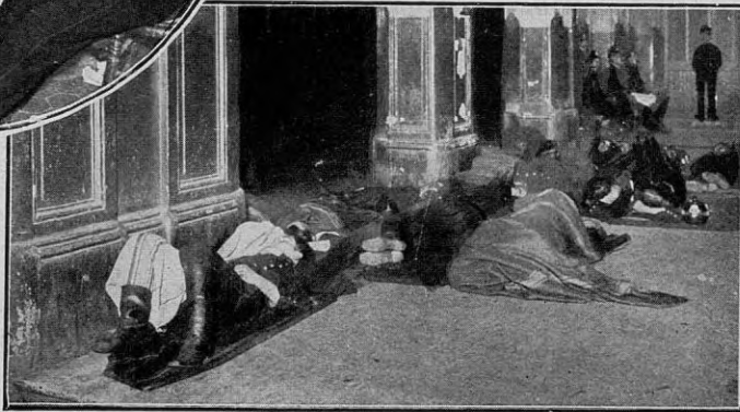
Vista de uno de los corredores, transformado en dormitorio por falta de local
