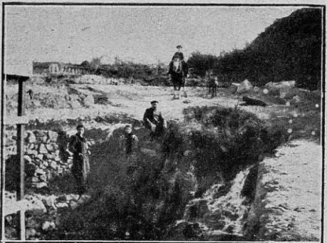
Vertiente de agua donde está instalada la bomba a que se refiere la anterior fotografía
