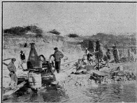
Puente sobre el arroyo Nahuel-Niyeo, kilómetro 151. — Bomba centrífuga secando las excavaciones para los cimientos de la obra
