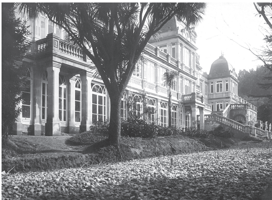
Fig. 8. Fachada principal (perspectiva lateral izquierda) del pazo de Lourizán tras la remodelación del inmueble. Foto Pintos, octubre 1912. AFMR
