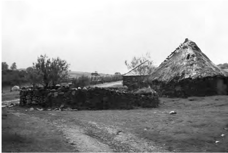
Foto 1: Alzada de Pandozarco. Vista parcial. Año 1996.
