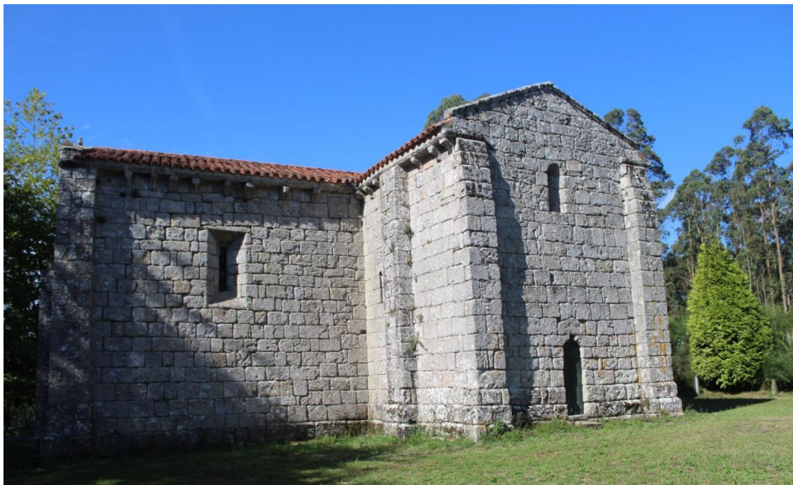
Figura 14. Muro meridional de san Miguel de Breamo (2020).
