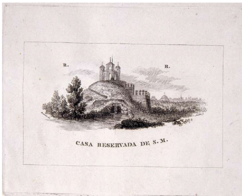
Fig. 29. Permiso de entrada a la casa reservada del rey. Fernando Brambila, 1841. Memoria de Madrid.
