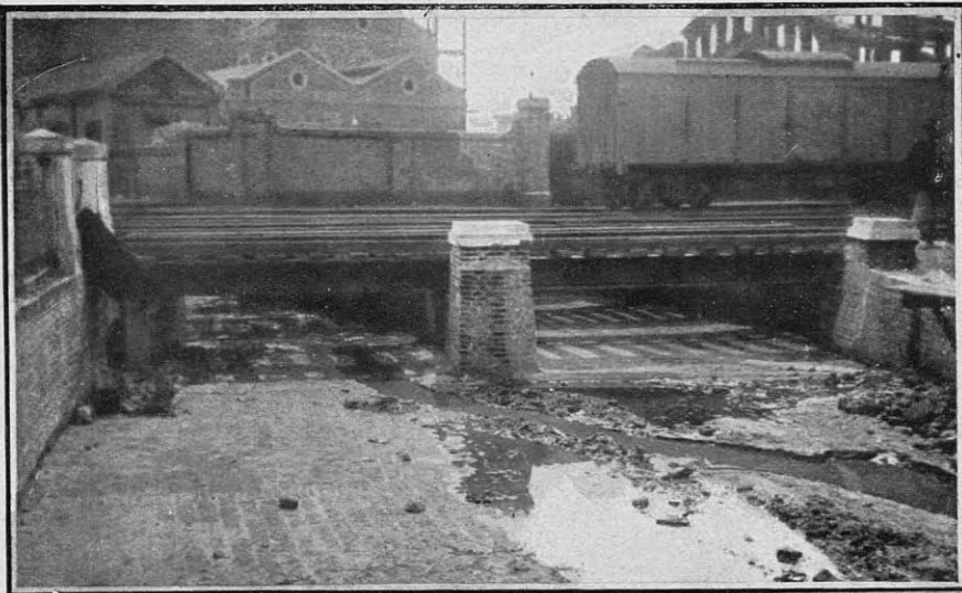
El anciano y retacón puente del F. C. C. A., a la altura de la calle Blanco Encalada, causante, en parte, de las últimas inundaciones. Será en breve reemplazado por otra obra de arte, con una superficie de desagüe de 14 metros
