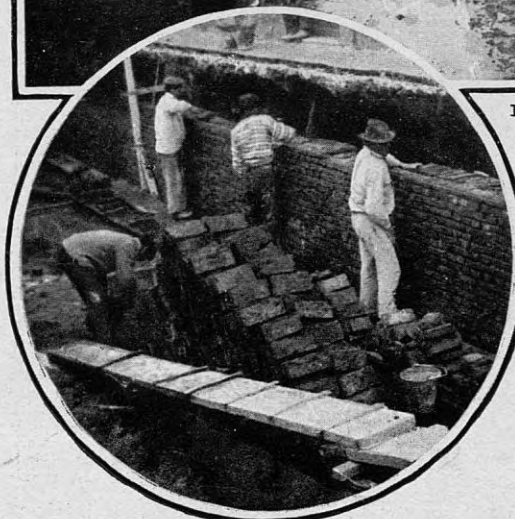
Levantando los muros de contención del zanjón Blanco Encalada, cuyo cauce ha sido ensanchado desde la avenida del Tejar hasta las vías del F. C. C. A. (este)
