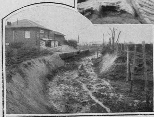
El desagüe de la calle Erezcano, a una cuadra del Riachuelo
