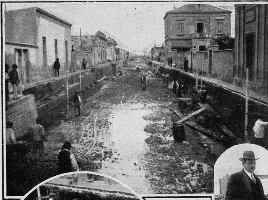
Levantando los muros de contención del zanjón Blanco Encalada, cuyo cauce ha sido ensanchado desde la avenida del Tejar hasta las vías del F. C. C. A. (este)
