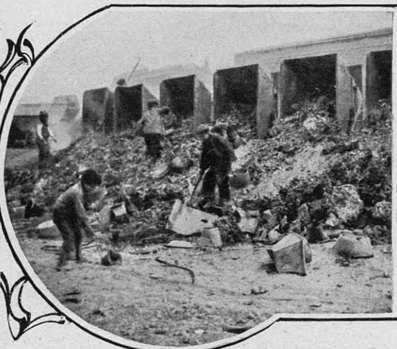
En Nueva Pompeya. — Levantando el nivel de la calle Trafal, con cenizas de la Quema de Basuras
