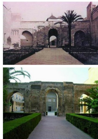
Figura 36: "Puerta de la Montería" antes y después de abrir los arcos laterales
