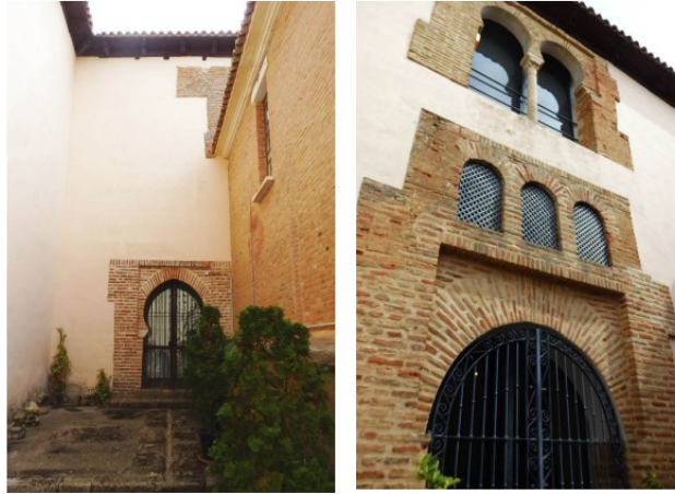
Figura 11: Puerta del zaguán al patio y puerta del salón septentrional al patio, "palacio de Astudillo"
