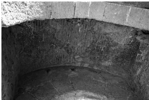
Figura 23: Bóveda de la puerta principal del "alcázar de Carmona"
