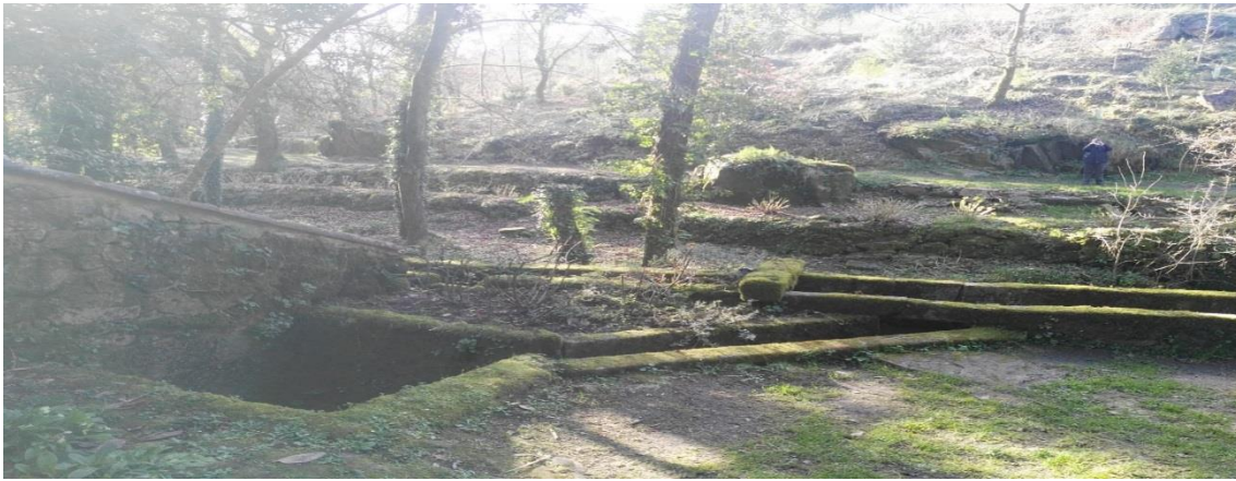
Figuran 47. Canalizaciones de la fábrica. Foto: la autora.
