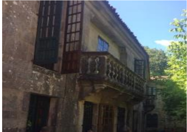
Figura 30. Fachada cuerpo lateral con balcón. Fuente: la autora
