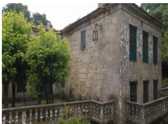
Figura 21. Lateral fachada de la terraza-mirador Fuente: (pazofaramello.com)
