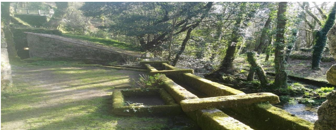
Figura 48. Canalizaciones de la fábrica y pudridero. Foto: la autora.
