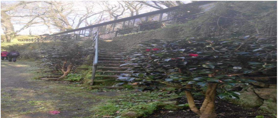
Figura 57. Escaleras del pabellón de celebraciones hacia paseo fluvial. Foto: la autora.
