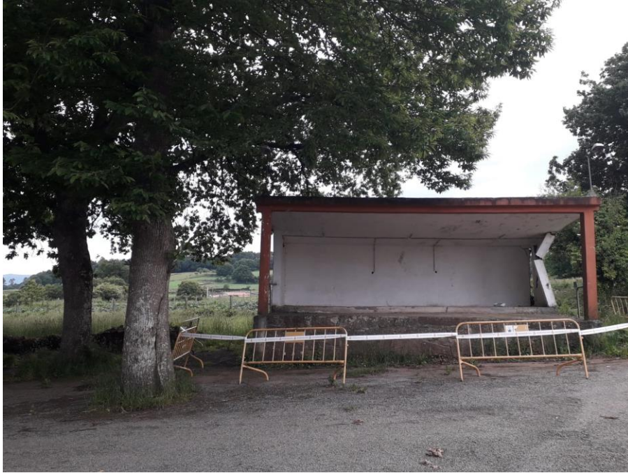
Palco do campo da festa de Pareizo no que se aprecia o golpe intencionado no lateral dereito
