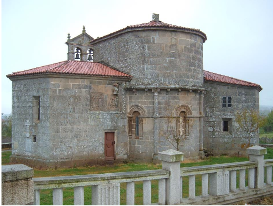
De esquerda a dereita: capela dos Gundín-Salgado, ábsida, e sancristía
